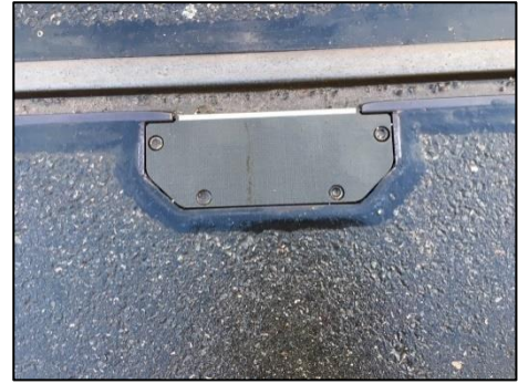
Abbildung 11-14: eingebauter Az-Kasten
