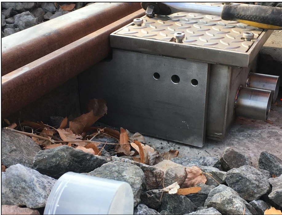
Abbildung 14-7: Beispiel Anbindung Erdungsanschlusskasten mittig
