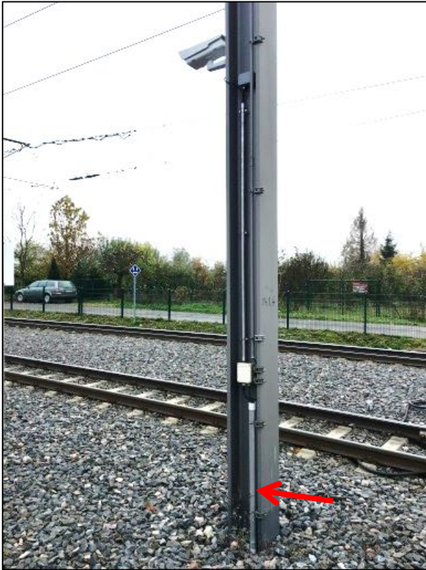
Abbildung 12-1: Videokamera am FL-Mast
