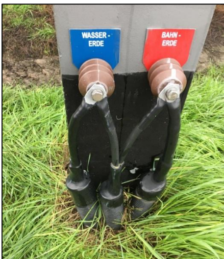
Abbildung 15-2: Beispiel Stützpunkte für Bahn- und Wassererde
