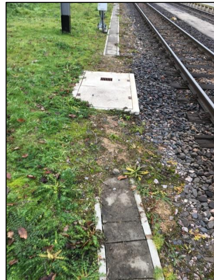
Abbildung 4-15: Trog abgesenkt eingeführt
