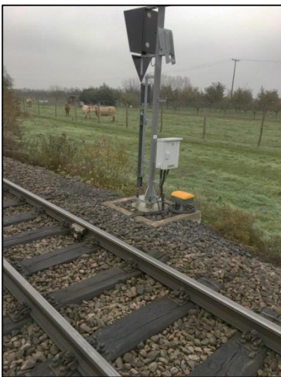
Abbildung 19-5: Beispiele Signaleinfassung mit Schachtzwischenrahmen der Größe T4
