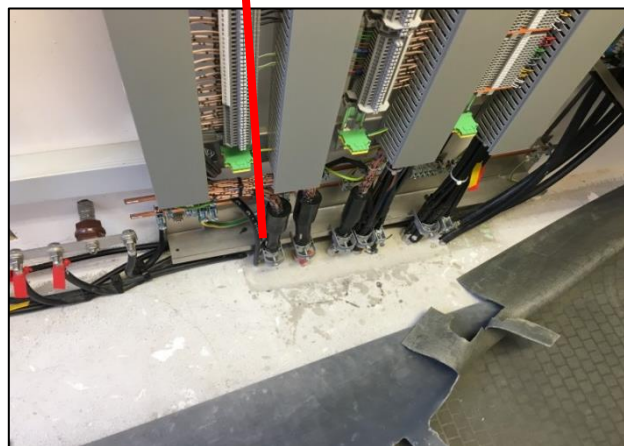
Abbildung 11-39: Praxisbilder Kabeleinführungsschacht am BÜ-Schalthaus
