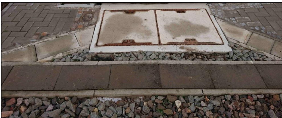
Abbildung 6-2: Einbindung Kabelschacht parallel zur Hauptkabeltrasse
