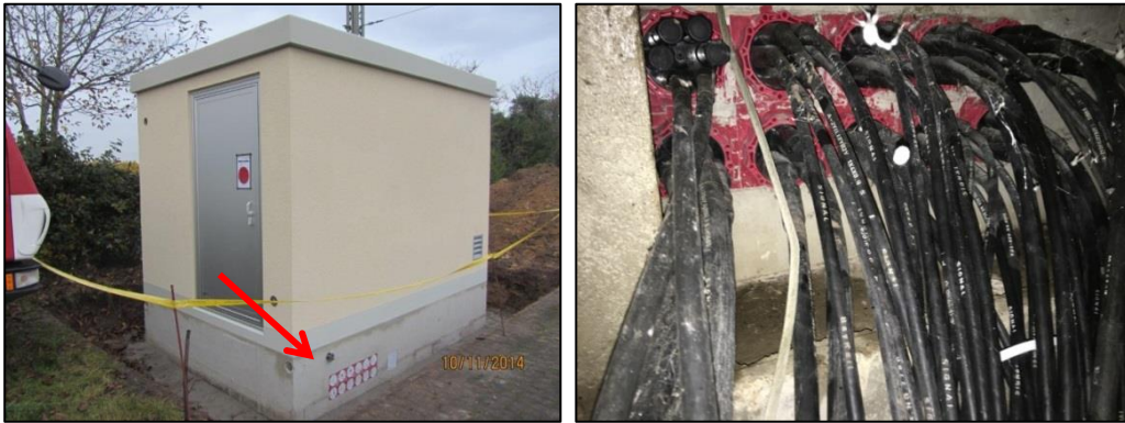
Abbildung 11-33: Kabeleinführungen im Kabelkeller des Stellwerksgebäudes
