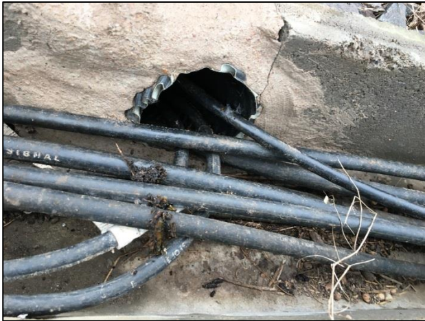
Abbildung 4-16: Leerrohreinführung Betonrog
