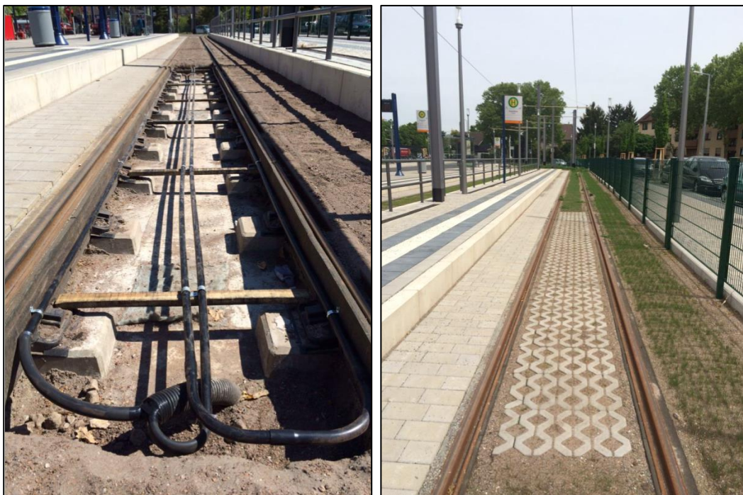
Abbildung 11-27: Anbindung Anforderungsschleife im Bereich fester Fahrbahn mit Rasengleiseindeckung
