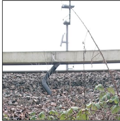
Abbildung 4-17: Leerrohreinführung aufgest. Kunststoffrog
