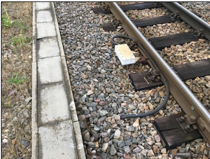
Abbildung 11-21: Koppelspule Typ A
