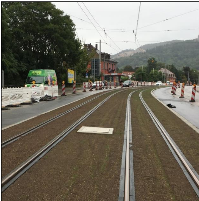
Abbildung 7-1: durchgehende Mittelrohrtrasse im Bereich mit eigenem Bahnkörper, bestehend aus fester Fahrbahn und Rasengleis
