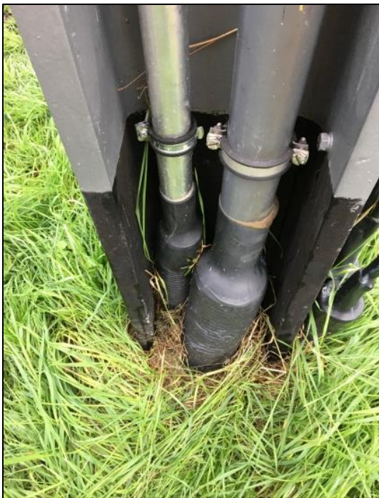
Abbildung 15-1: Beispiel Anbindung Einspeisung Fahrleitung am FL-Mast
