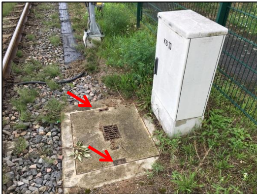
Abbildung 11-32: Anordnung Schacht vor Kabelschrank
