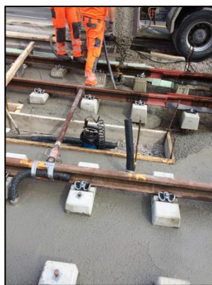
Abbildung 11-6: nach Betonage
