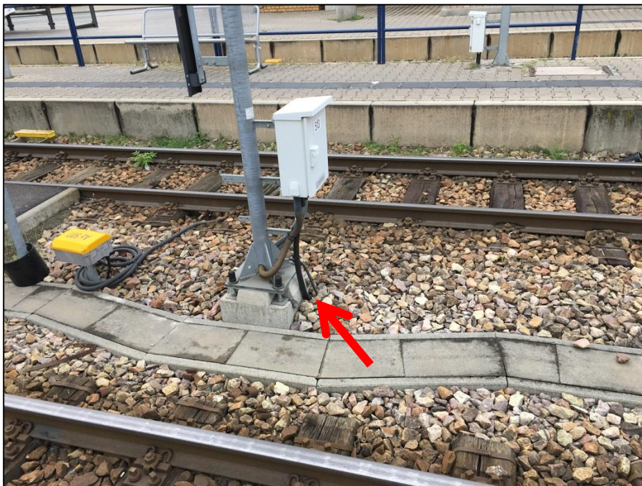
Abbildung 11-2: Beispiel Anbindung Zugsicherungssignale Typ A
