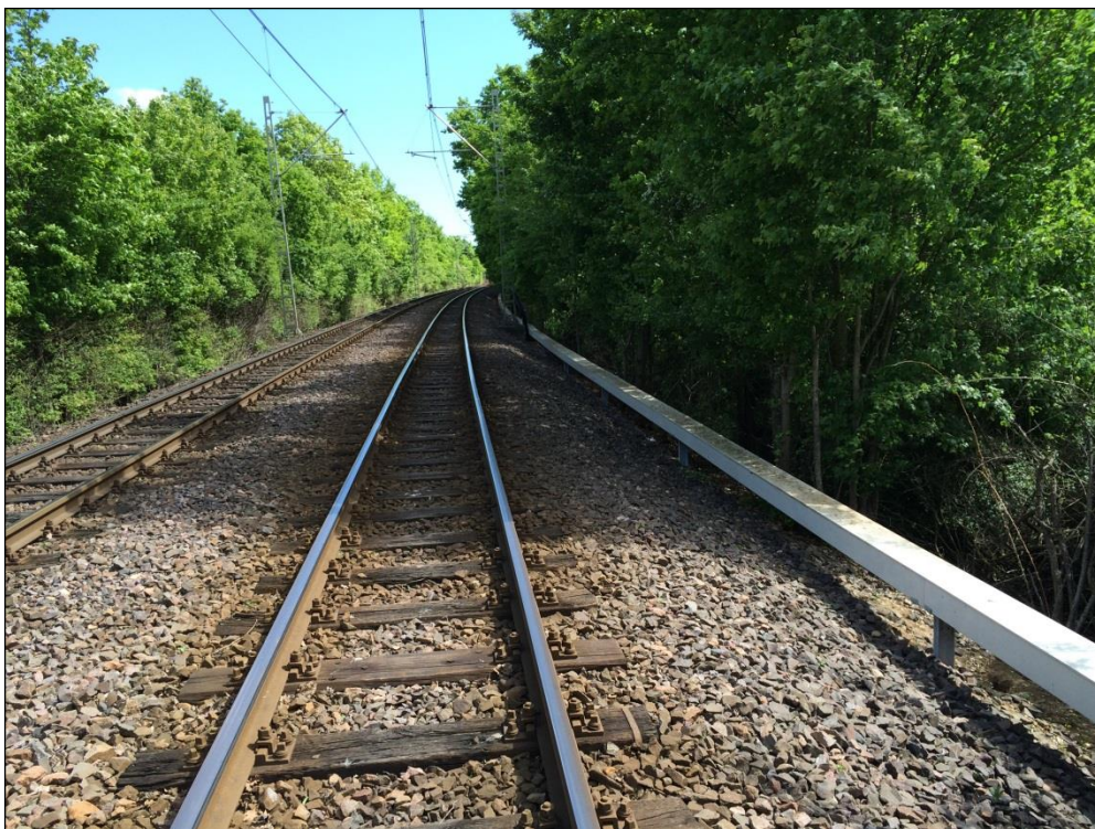
Abbildung 4-11: Aufgeständerter Kunststoffkabelkanal Größe 2
