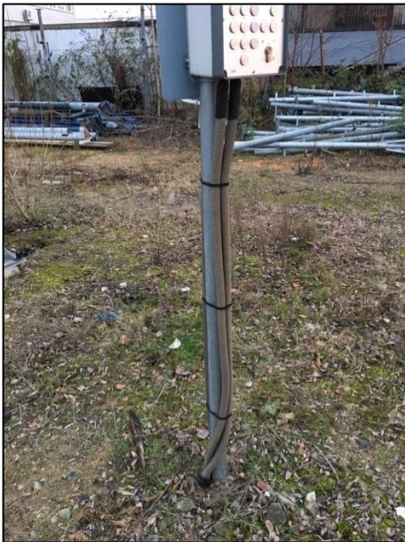
Abbildung 11-29: Anbindung Bedientableau
