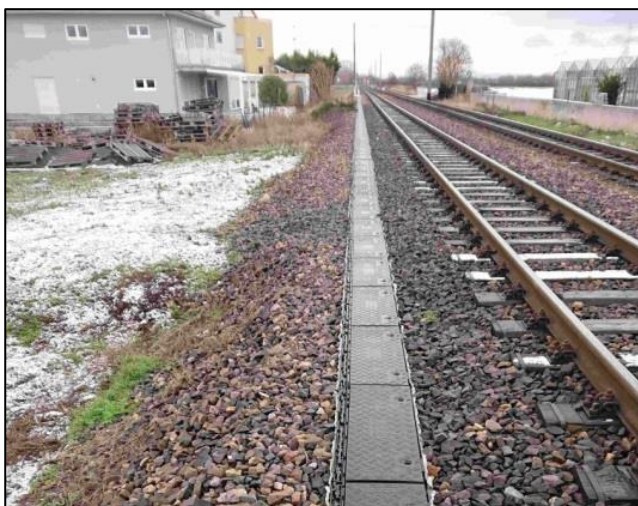
Abbildung 4-10: Erdverlegter Kunststoffkabelkanal Größe II
