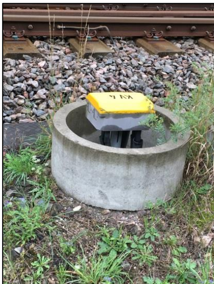
Abbildung 19-7: Betonring als Schutz gegen Beschädigung beim Grünschnitt
