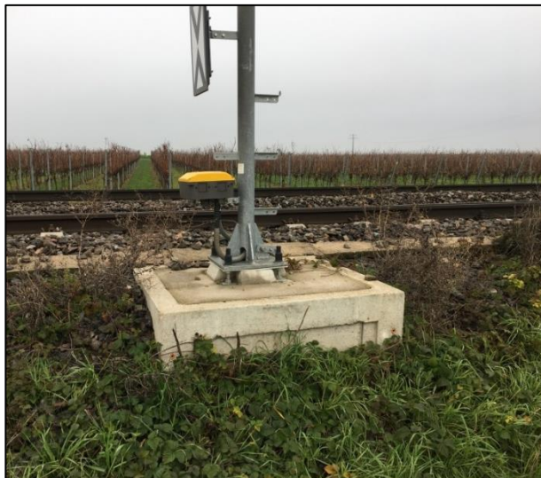
Abbildung 19-5: Beispiele Signaleinfassung mit Schachtzwischenrahmen der Größe T4
