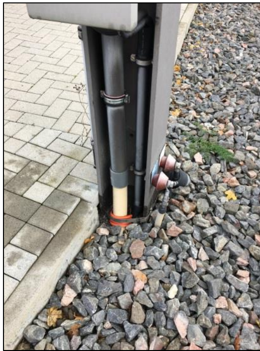
Abbildung 15-1: Beispiel Anbindung Einspeisung Fahrleitung am FL-Mast
