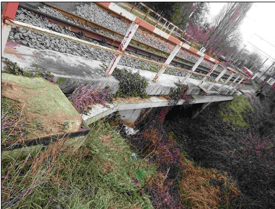
Abbildung 4-13: Brückentrog als Kunststoffkabelkanal
