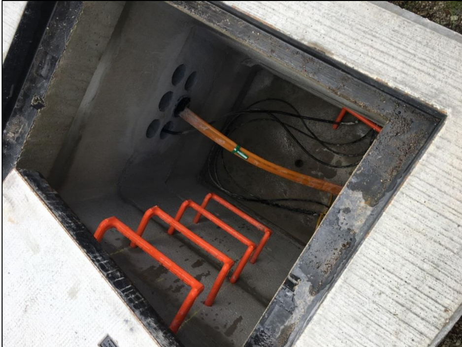
Abbildung 4-6: Muster Schachteinbau
