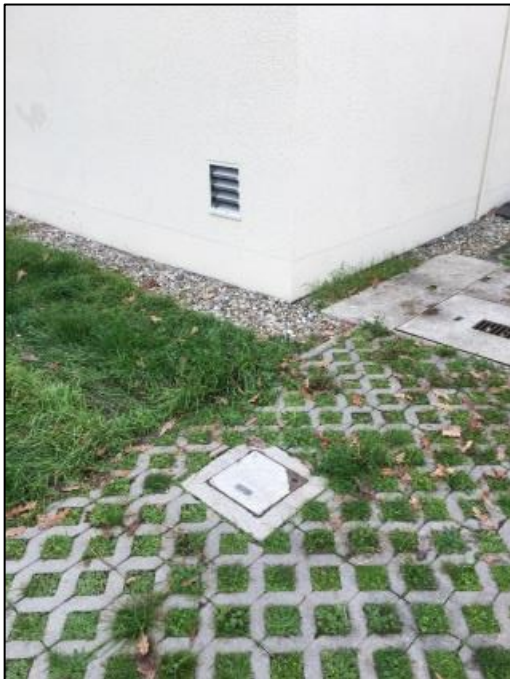
Abbildung 11-35: Kleinschacht zum Schutz des Tiefenerders
