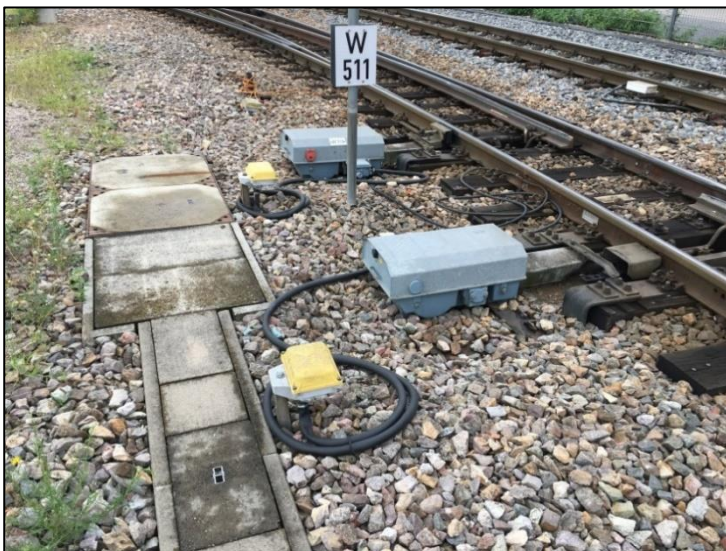
Abbildung 4-14: Trogeinführung mit Absenkbausatz
