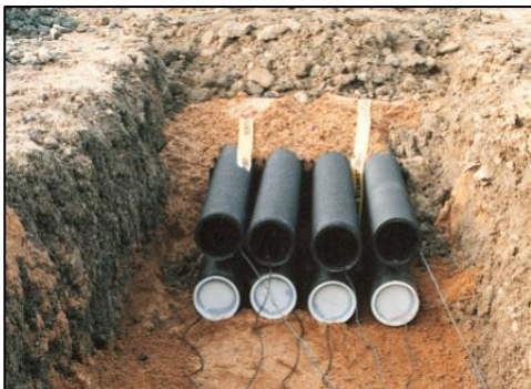
Abbildung 4-18: eingesandete Leerrohrverlegung
