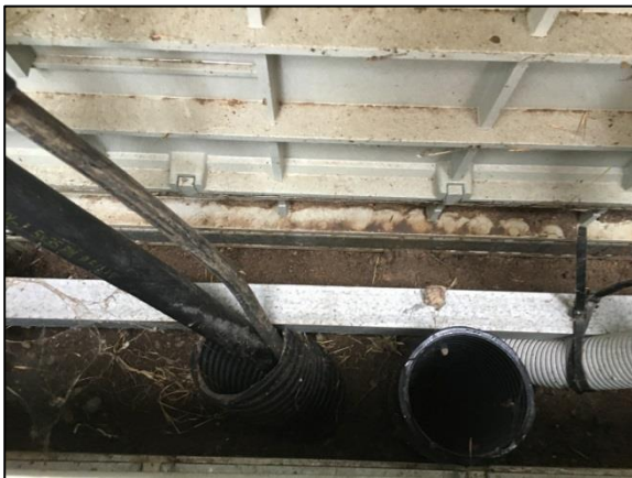
Abbildung 11-31: Anbindung Schranksockel mit Leerrohren
