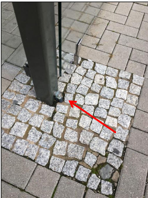
Abbildung 14-2: Erdanschluss Fahrgastunterstand und Sitzbank
